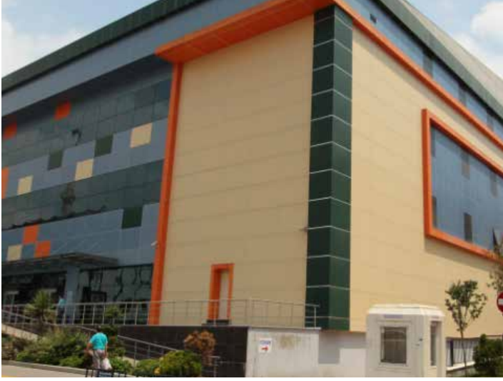
SIYAVUŞPAŞA SPOR KOMPLEKSİ
